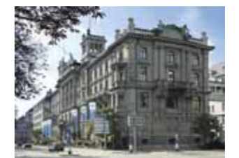
チューリッヒグループ本社ビル
